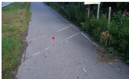
Detektor med induktiv sløyfe for sykkel. Rødt punkt viser hvor geometri skal registreres
