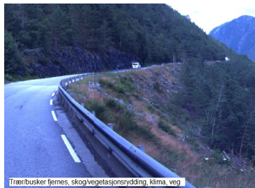
Trær/busker fjernes, skogvegetasjonsrydding, klima, veg
