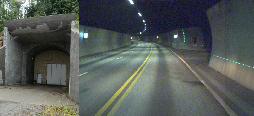
Tverrslag på utsida og i tunnel
