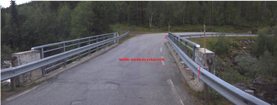
Rekkverk på/ved bru. Foto: Statens vegvesen
