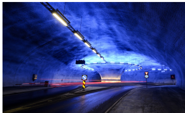
Lyssetting i Vallaviktunnelen. Foto Knut Opeide
