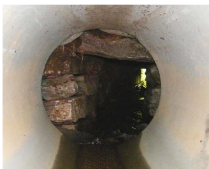
Figur 8: Stikkrenne som er forlenget
