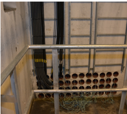
Trekkerør inn til hovedfordeling. Foto: Tore Paulsen
