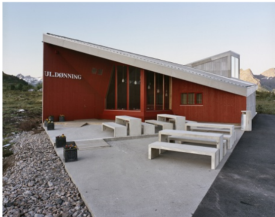
Figur 3: Eksempel på toalettanlegg i privat bygg
