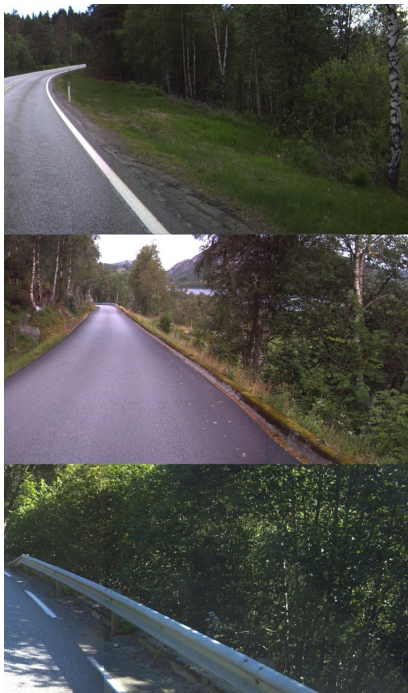
Redusert klippebredde på grunn av busker og trær. Foto: Statens vegvesen.
