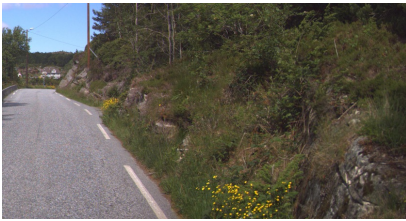
Foo: Statens vegvesen
