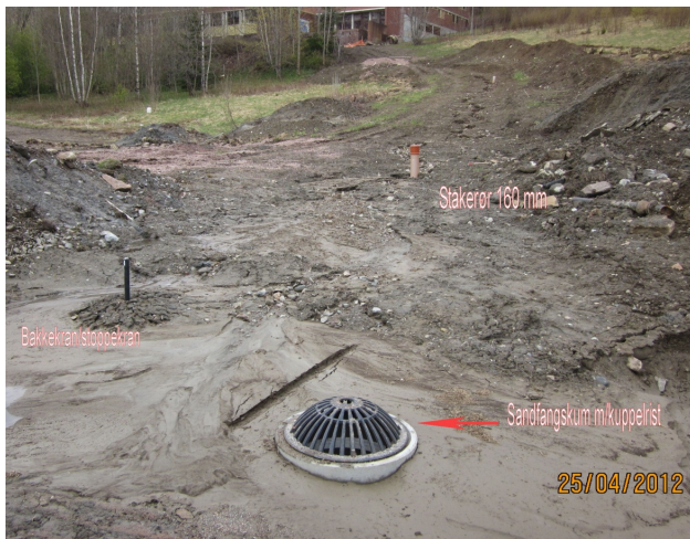
Sandfangskum, bakkekran og stakerør. Foto Terje Rønneberg
