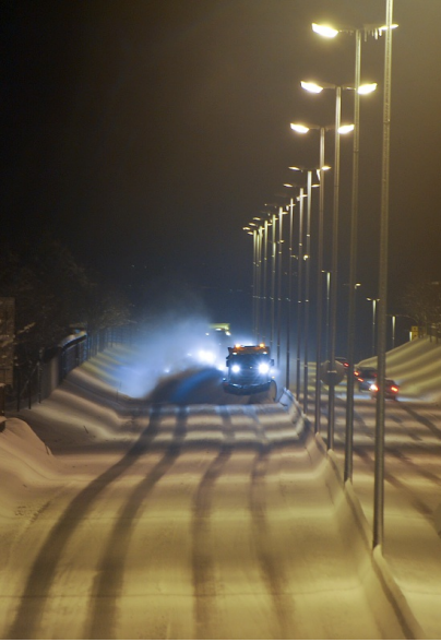
Lyssetting langs midtdeler på omkjøringsveien i Trondheim. Foto Knut Opeide
