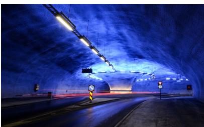
Lyssetting i Vallaviktunnelen. Foto Knut Opeide
