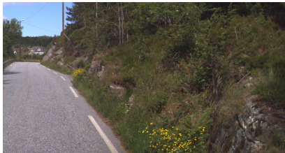
Foo: Statens vegvesen
