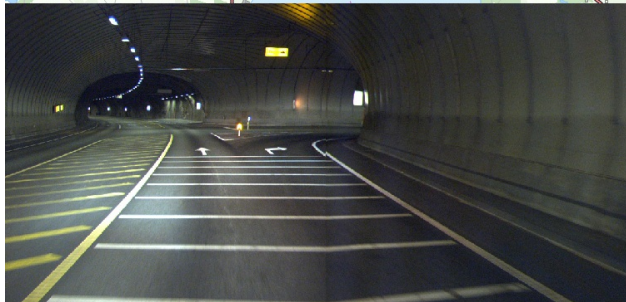
T-kryss i tunnel
