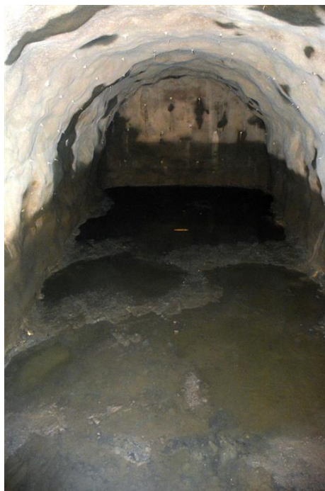
Pumpesump: Foto: Tore Paulsen
