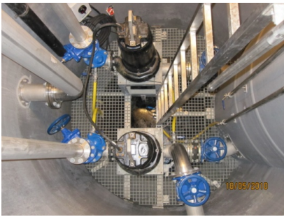
Pumpestasjon i kum. Foto: Terje Rønneberg
