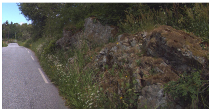
Fto Statens vegvesen
