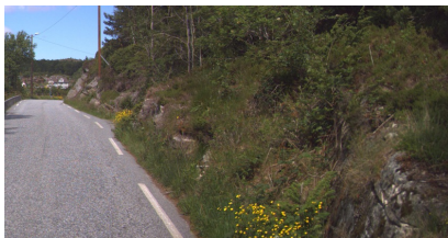
Foo: Statens vegvesen
