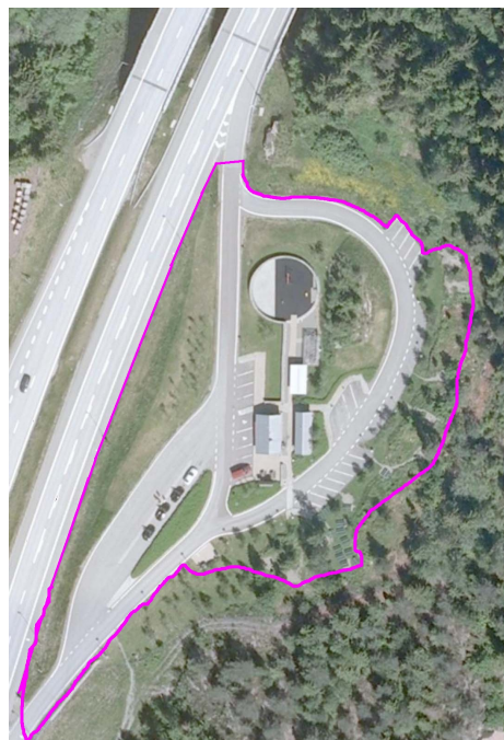
Eksempel på stor rasteplass med adkomst bare fra en kjøreretning
