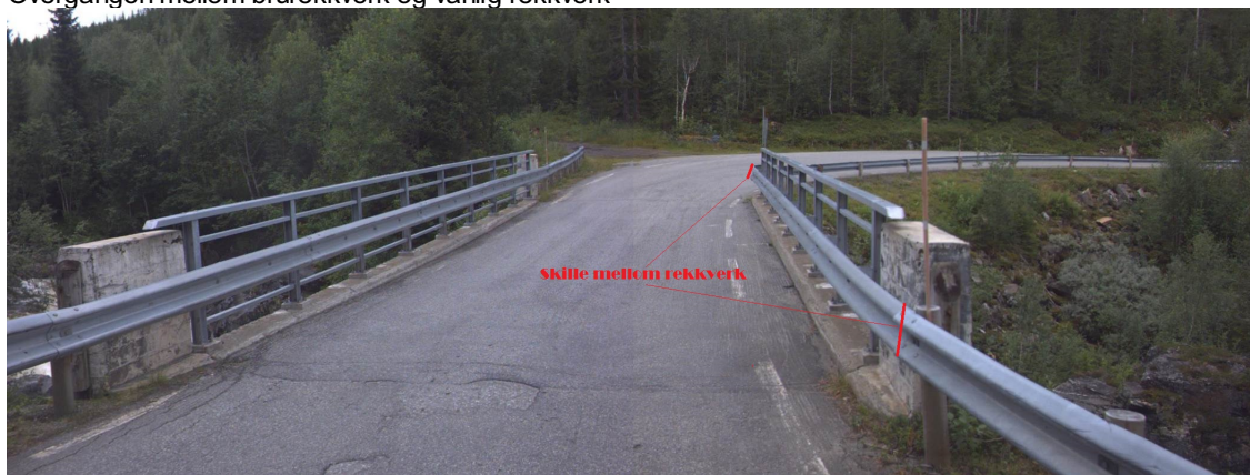
Rekkverk på/ved bru. Foto: Statens vegvesen
