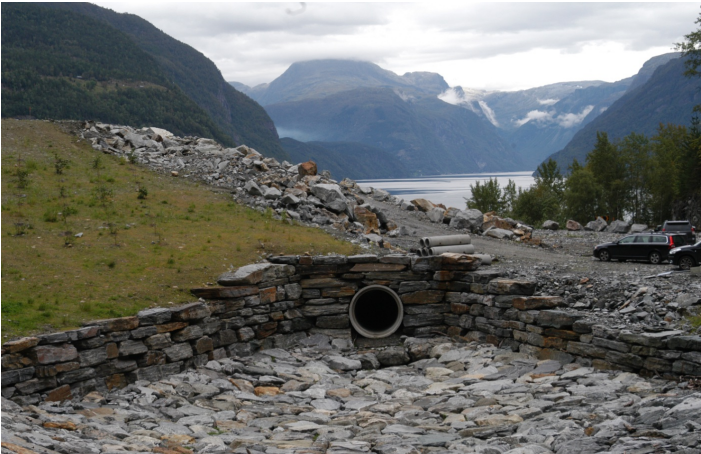
Figur 3: Skredmagasin. Foto: Geir Brække
