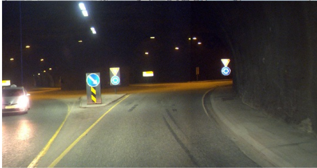
Rundkjøring i tunnel
