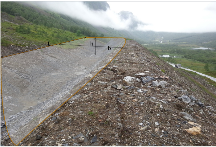
Figur 5: Volumberegning av skredmagasin med en stor voll. Foto: Knut Inge Orset
