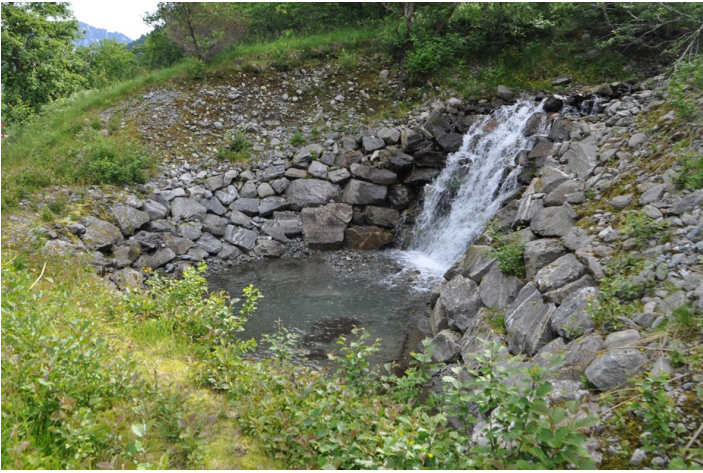
Figur 7: Sikring for sørpeskred/flomskred. Foto: Marie Drågen
