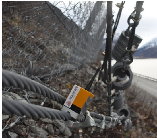
Figur 4: Rystelsesmåling på fanggjerde. Foto: Halgeir Dahle
