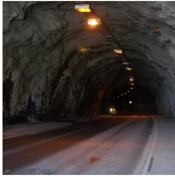
Figur 6: Kabelstige i tunneltak i Flekkerøytunnelen. Foto Kjell Wold
