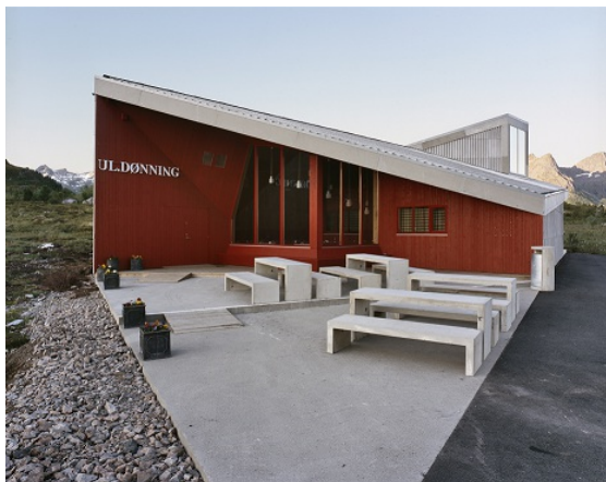
Figur 3: Eksempel på toalettanlegg i privat bygg
