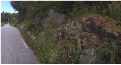
Fto Statens vegvesen
