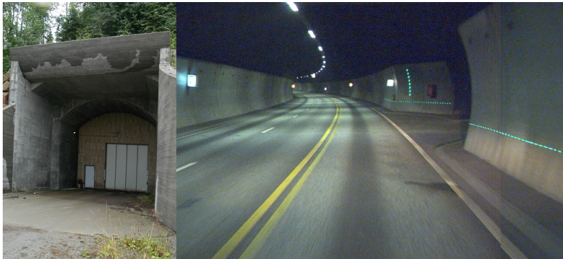
Tverrslag på utsida og i tunnel
