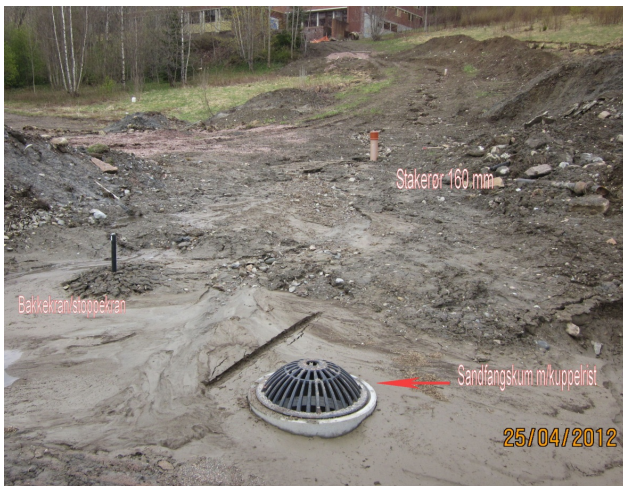
Sandfangskum, bakkekran og stakerør. Foto Terje Rønneberg
