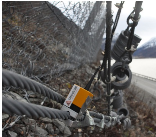
Figur 4: Rystelsesmåling på fanggjerde. Foto: Halgeir Dahle
