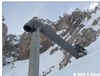
Figur 4: Skredutløsning med GazEx
