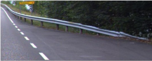
Nedføring i bakken med og uten utsvinging
