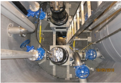
Pumpestasjon i kum. Foto: Terje Rønneberg
