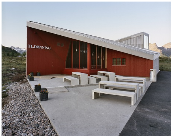
Figur 3: Eksempel på toalettanlegg i privat bygg
