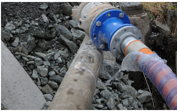
Figur 4: Rørledninger tilhørende veganlegg. Foto: Anja Kristin Bakken
