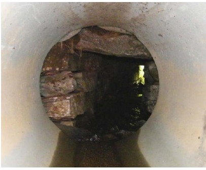
Figur 8: Stikkrenne som er forlenget
