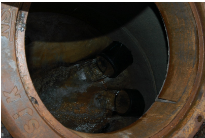
Kum i tunnel. Foto: Kjell Wold
