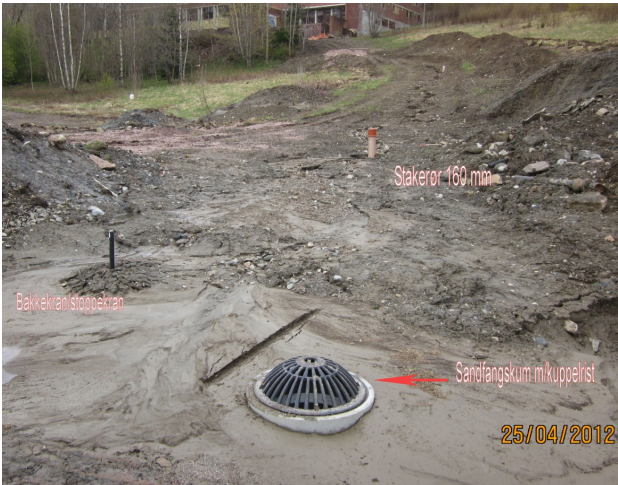
Sandfangskum, bakkekran og stakerør. Foto Terje Rønneberg
