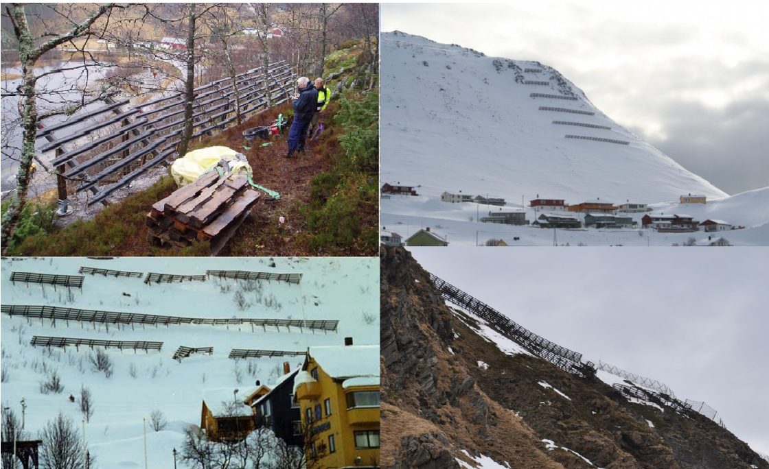
Eksempler på støtteforbygninger. Foto NGI (øverst til venstre), Jan Otto Larsen (øverst til høyre), Statens vegvesen (nederst)
