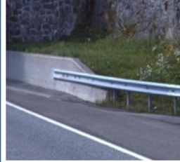
Sideforankring i mur og jordskjæring
