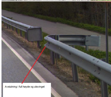
Sideforankring i fjellskjæring
