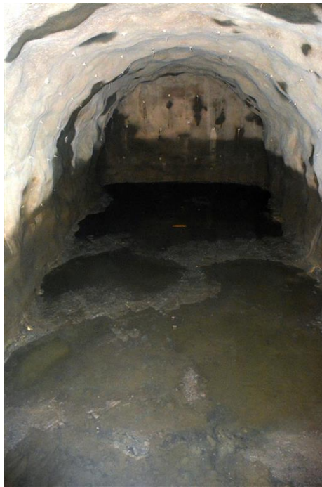
Pumpesump: Foto: Tore Paulsen
