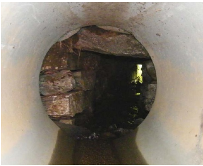
Figur 8: Stikkrenne som er forlenget
