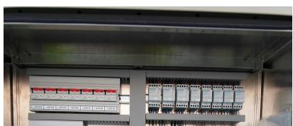
Bildet viser et veglysskap fra Kåfjordtunnelen. Skapet inneholder også en fibernode.
