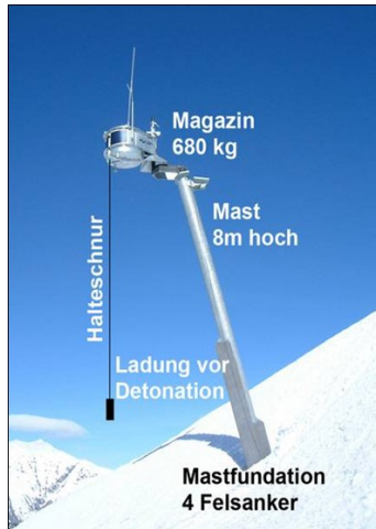
Figur 3: Skredutløsning med Wysstentårn. Foto: Wyssen avalanche control AG
