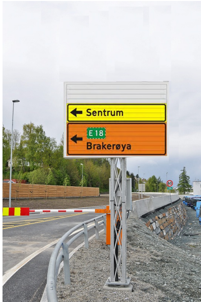
Bildet viser et prismeskilt som normalt kan ha inntil 3 budskap. Foto: Knut Opeide og Håndbok V321 (053)
