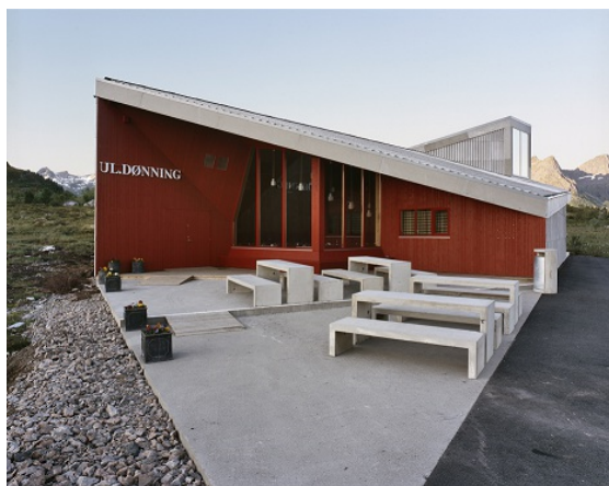
Figur 3: Eksempel på toalettanlegg i privat bygg
