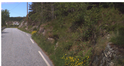
Foo: Statens vegvesen
