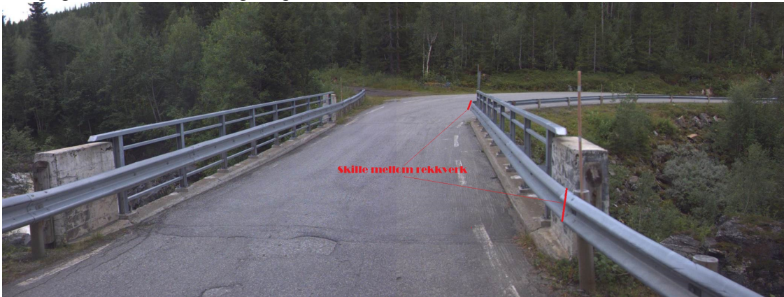
Rekkverk på/ved bru. Foto: Statens vegvesen
