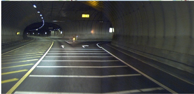
T-kryss i tunnel
