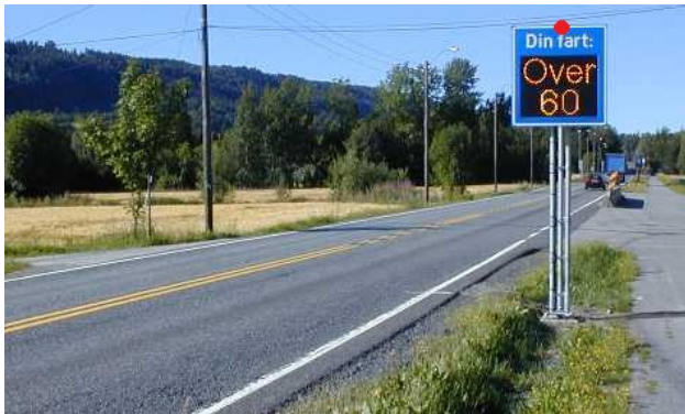
Fartstavle måles inn i senter topp tavle som vist her med rød prikk
