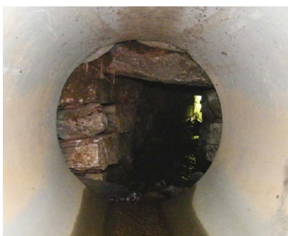
Figur 8: Stikkrenne som er forlenget
