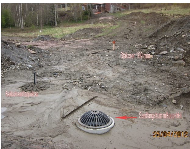
Sandfangskum, bakkekran og stakerør. Foto Terje Rønneberg
