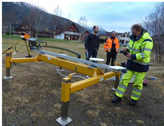
Figur 3: Utstyr for skredvarsling med radar
